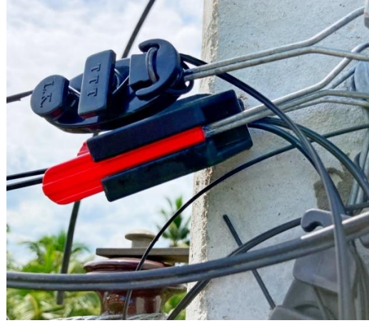
ภาพประกอบที่ 15. ติดตั้งสายต้นแบบ Access OFC Nylon-6 กับอุปกรณ์จับยึดฯ Nylon-6/ABS
