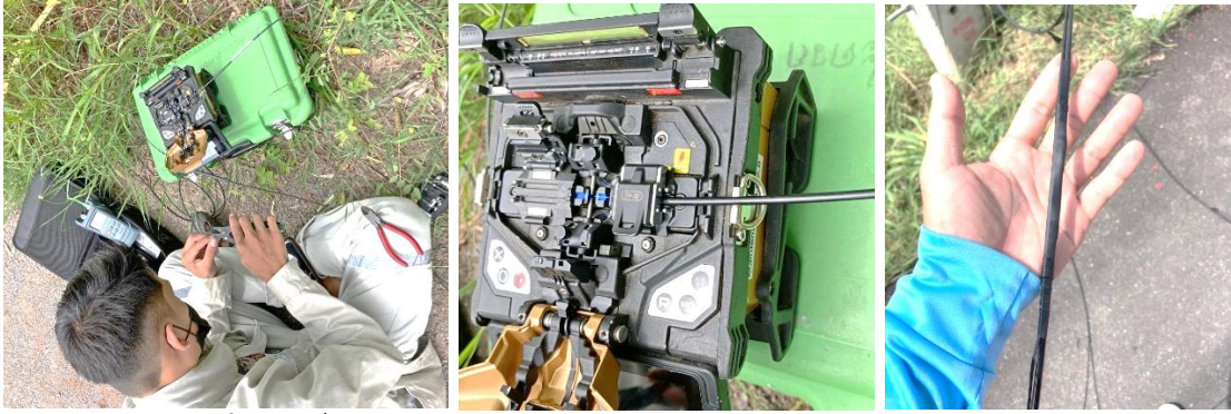
ภาพประกอบที่ 12. เชื่อมต่อสายต้นแบบ Access OFC Nylon-6 กับอุปกรณ์โครงข่าย ODN
