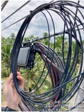
ภาพประกอบที่ 15. ติดตั้งสายต้นแบบ Access OFC Nylon-6 กับอุปกรณ์จับยึดฯ Nylon-6/ABS
